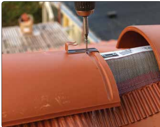
Nockklammer och panna fästes med rostfri skruv
