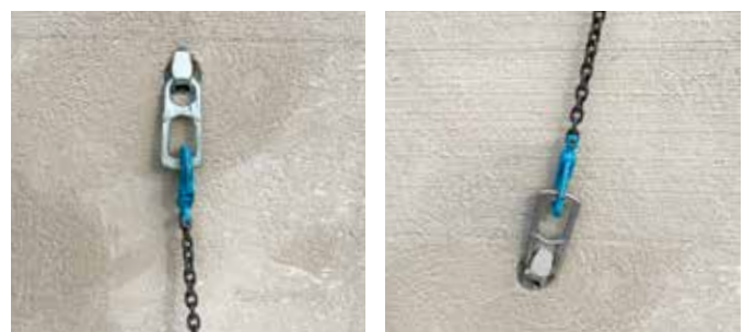
Fig 3.4 Våldsamma ryck vid resning av T-mur kan motverkas med dämpande material-
