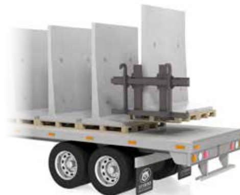
Fig 2.2 Lossning av T-stöd med gafflar
