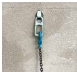
Fig 3.4 Våldsamma ryck vid resning av T-mur kan motverkas med dämpande material-
