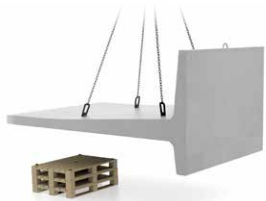
Fig 3.1 Lyft av T-stödmur i alla ankarpunkter.
