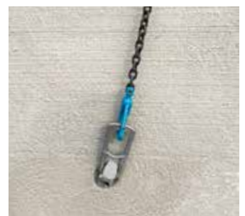
Fig 3.4 Våldsamma ryck vid resning av T-mur kan motverkas med dämpande material-
