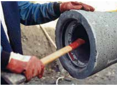
1. Vid stark kyla eller is; knacka på tätningsringen. Använd inte gasol!
