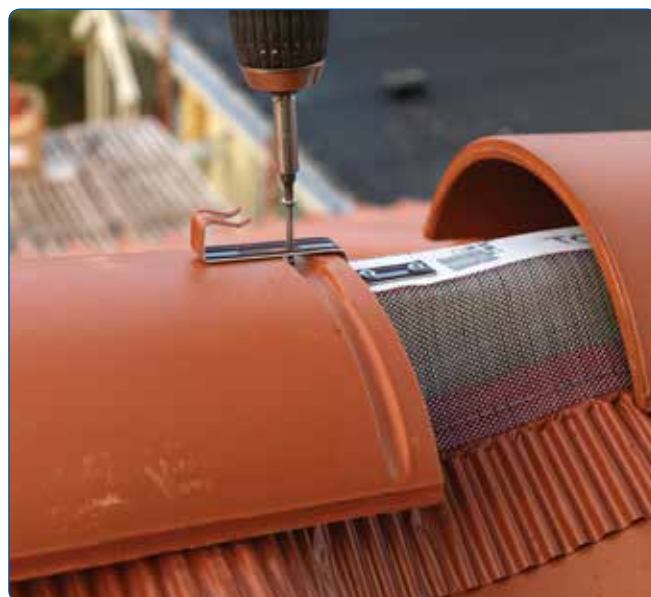
Nockpanna, nockklammer, nocktättningsrulle
