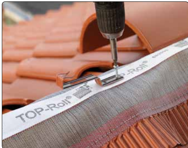
Nockklammer fästes med rostfri skruv
