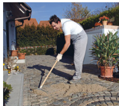
2-komponents fogbruket PCI Pavifix PU, är vattengenomsläppligt och stenbeläggningsen skall läggas på dränerande bärlager, så att regnvatten kan dräneras ner i marken.
