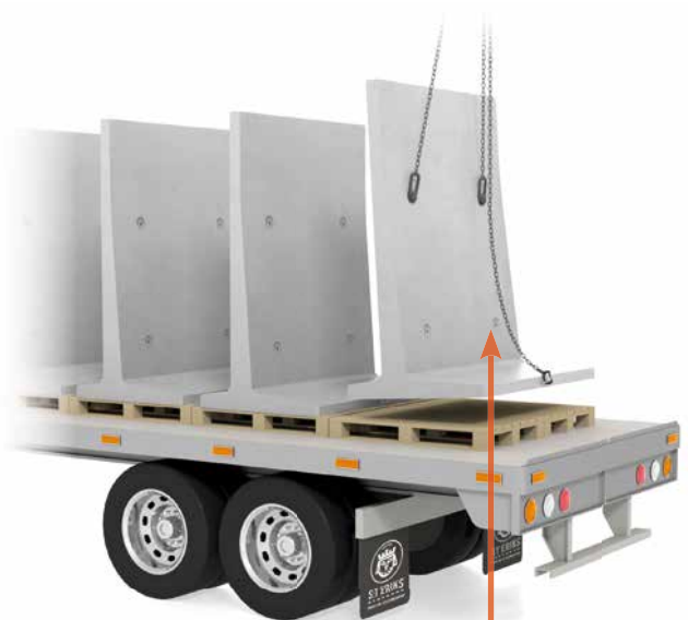
Fig 1.4 Lossning med kulhanskar och lyftkedjor
