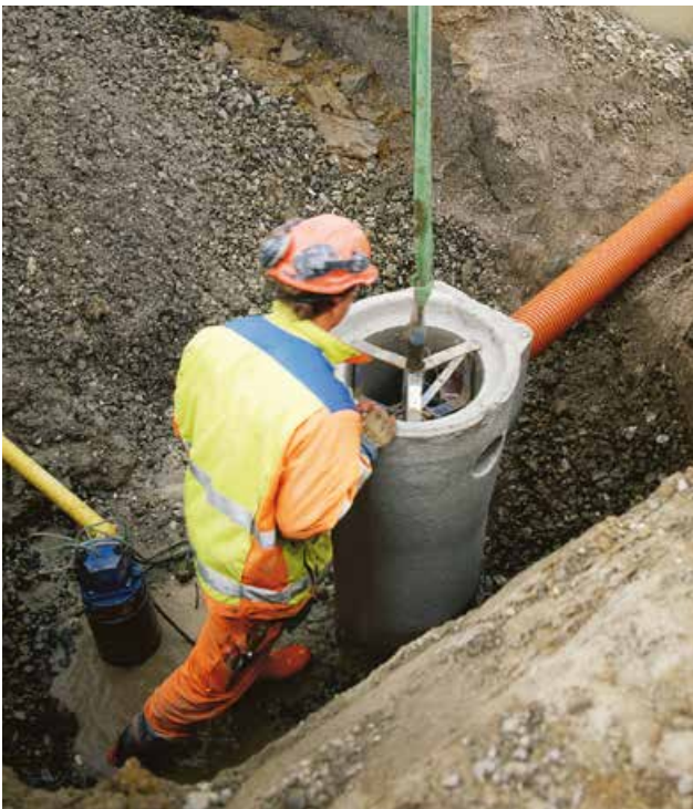
Montage av DRB brunnar.
