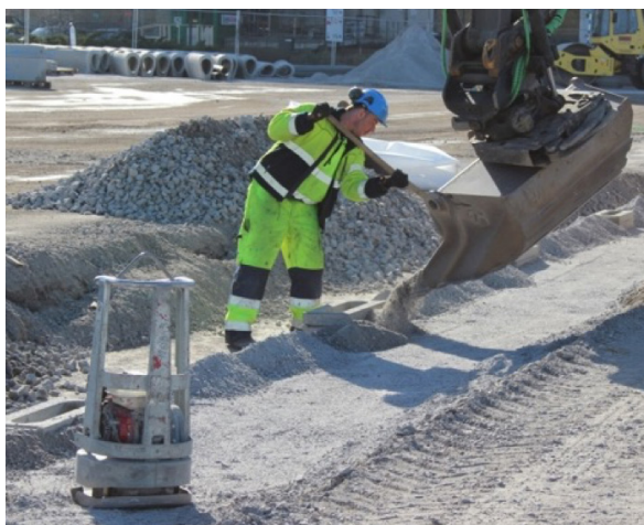
Stockholms hamnar. Kringfyllning av ledning och understoppning av betäckning
