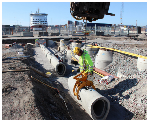
Stockholms hamnar. Byggande av dagvattenränna, vartannat rör med ränna.
