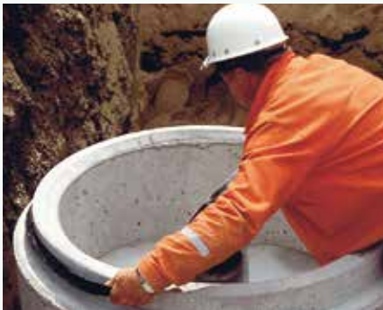
1. Montera fogpackningen på spetsen före nedlyftning av MAX-mellandelen i rörgraven. Vänd packningen rätt, placera den på klacken med spetsen upp.
