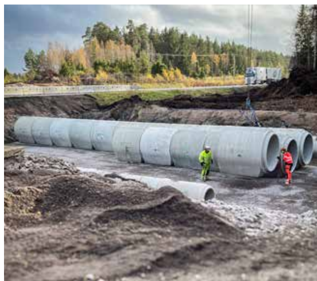
Installation av dagvattenmagasin
