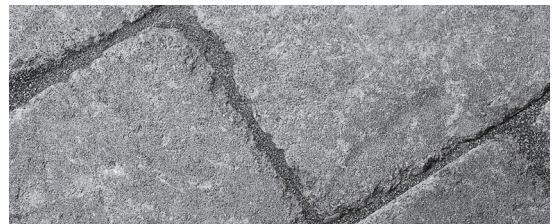
4. Normalt härdar fogen på 1-3 dygn vid en temperatur på ca 15°.
