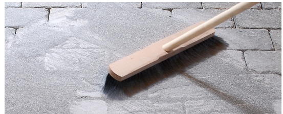
2. Borsta ner fastfogen i fogarna, var noga med att inte lämna kvar spill av fastfogen på marksten/plattorna.
