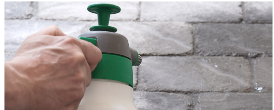
3. Spraya ytan med vatten tills fastfogen är helt genomfuktad. Låt inte uppblandat vatten och fogsand stå kvar på ytan!
