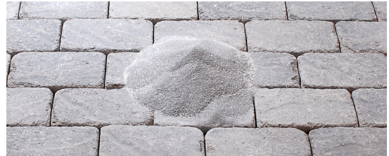
1. Fördela S:t Eriks Fastfog jämt över den helt torra beläggningssytan.
